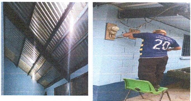
Foto 5: Sustitucion de focos ahorradores, plafoneras y ducto electrico y sus accesorios.
